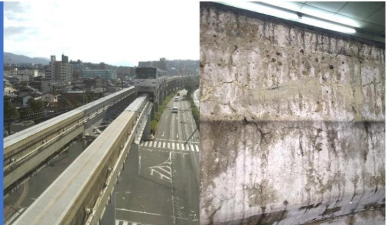
ここでは、地道なひずみモニタリング計測と、通年の載荷試験から得られた変位挙動から、PC桁のアルカリ骨材反応(以下、ASR)による膨張挙動を時系列に把握することが可能となった事例を紹介します。
