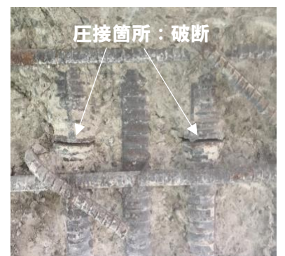
【主鉄筋継手部圧接箇所の破断】
