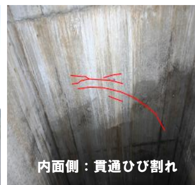
【P3 橋脚貫通ひび割れ】
