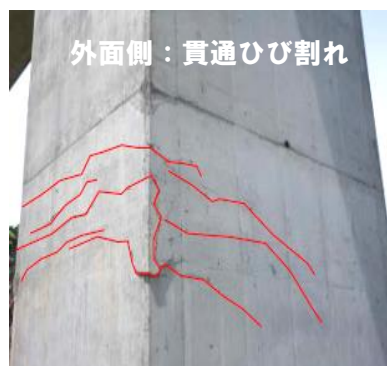
【P3 橋脚貫通ひび割れ】
